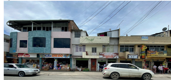
Figura 91. Fachada vivienda de uso mixto
