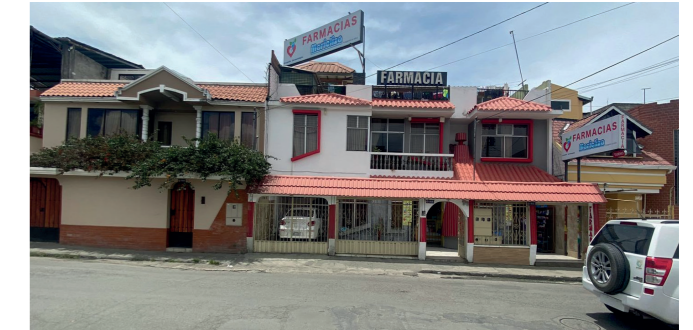
Figura 92. Fachada vivienda de uso mixto
