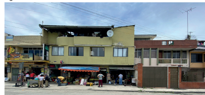
Figura 93. Fachada vivienda de uso mixto
