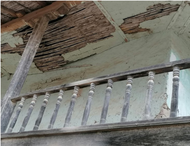
Imagen 16. Patología física en tumbado de revoque de lodo.
