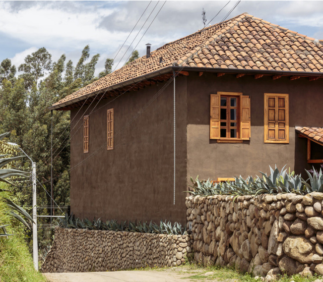
Imagen 9. Sistema constructivo en adobe
