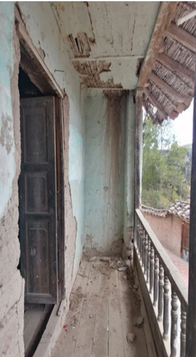
Imagen 17. Patología química en paredes de edificación.
