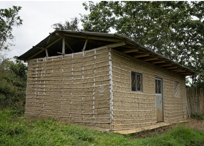
Imagen 10. Sistema constructivo en bahareque
