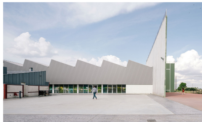
Figura 4. Exterior del Pabellón polideportivo de Villacelama
