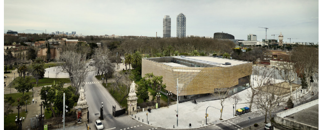
Fuente: Archdaily (2013, 8 de Enero). Edificio Polideportivo.
