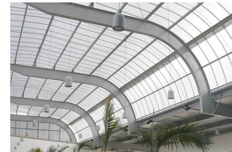
Estructura de aluminio para piel de vidrio serie PV 1100 (perfiles 2364/1454, 2363/1456), vidrio laminado de 3mm+3mm+0.75PVB, cinta adhesiva para piel de vidrio de 25mmx3mm, silicona, caucho para relleno de juntas, herrajes para ensamble de estructura
