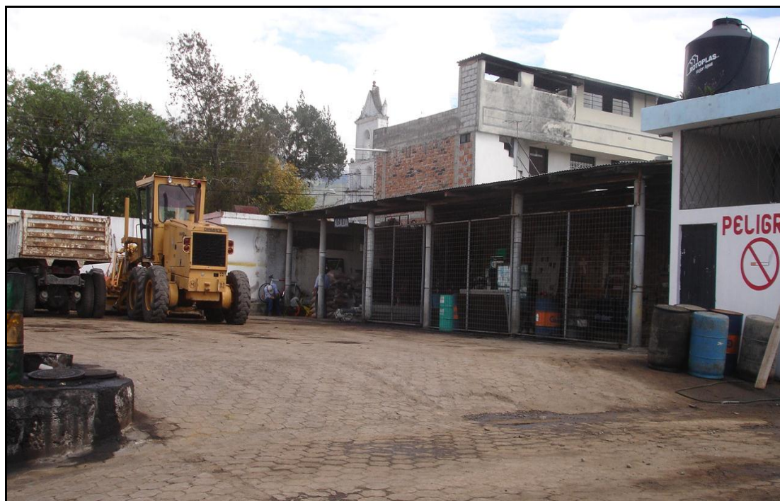
Figura 18: Taller de mantenimiento mecánico
