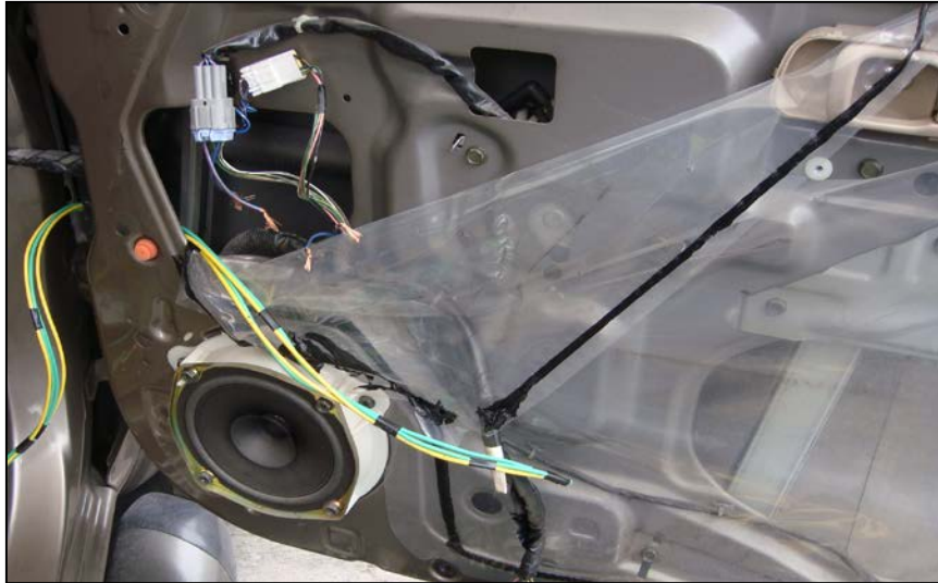
Figura 5.3. Desmontaje Paneles Puertas.
