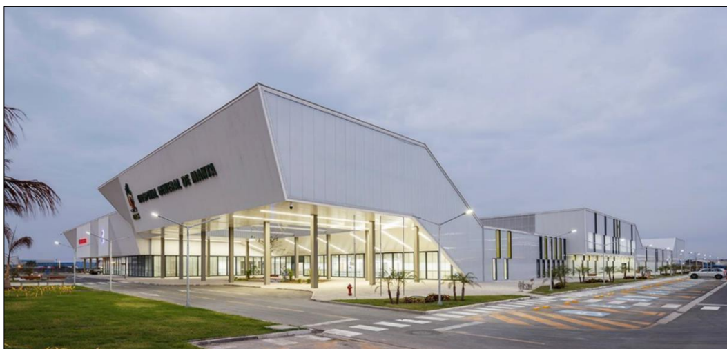
Ilustración 5: Fachada del Hospital general de Manta, Ecuador (Área construcción 24.100 m2), (sitio web)
