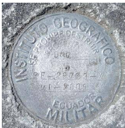
Imagen 16: Placa IGM de control horizontal y vertical
