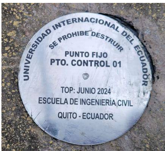
Imagen 13: Placa de acero inoxidable de identificación de cada hito de la red de control geodésica
