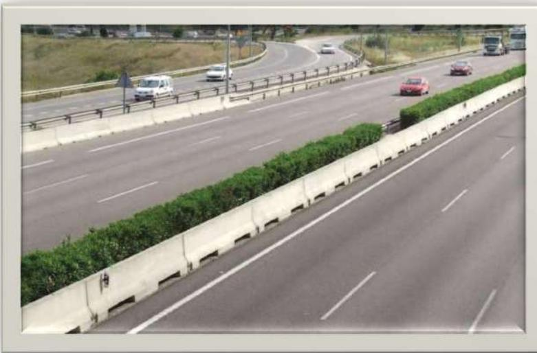
*Nota.* Barandas de seguridad de hormigón; Adaptado de; (Olivera, Y., Guevara, S. y Muñoz, S, 2022).
