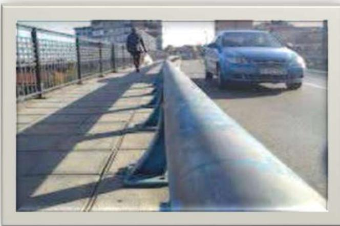
**Nota.** Barandas de seguridad de viga tubular; Adaptado de; (González, M., Cobo, A., Llaurado, N., Castaño, A. y Prieto, I, 2022).
