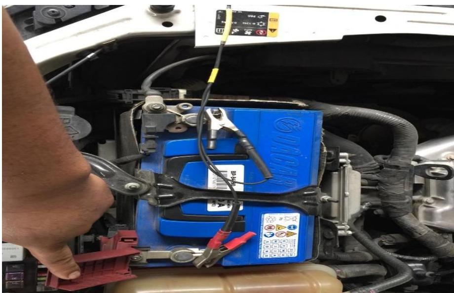
Como siguiente paso se conecta la pinza amperimétrica para medir corriente en el circuito eléctrico, es importante conectarla correctamente y tener en cuenta la dirección de la corriente, si se conecta en el polo negativo la flecha debe apuntar en sentido contrario y si se conecta al polo positivo la flecha debe apuntar al borne positivo tal y como se indica en la figura 22.
