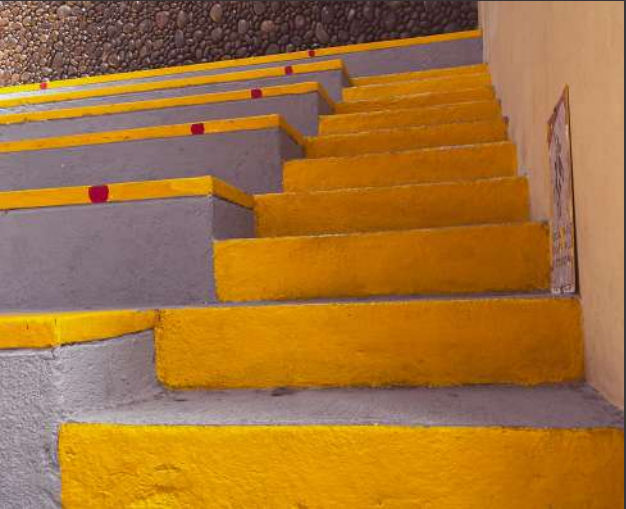
Imagen 27. Circulación Vertical Graderíos Fuente y Editado por el Autor, 2024
