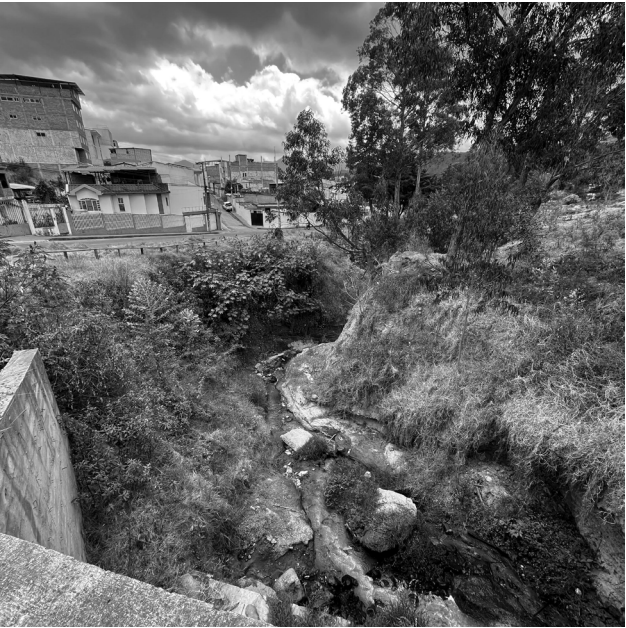
Imagen 100. Fotografía Escala Humana Quebrada Abierta “Punzara” Oeste - Este Fuente y Elaborado por el autor, 2024
