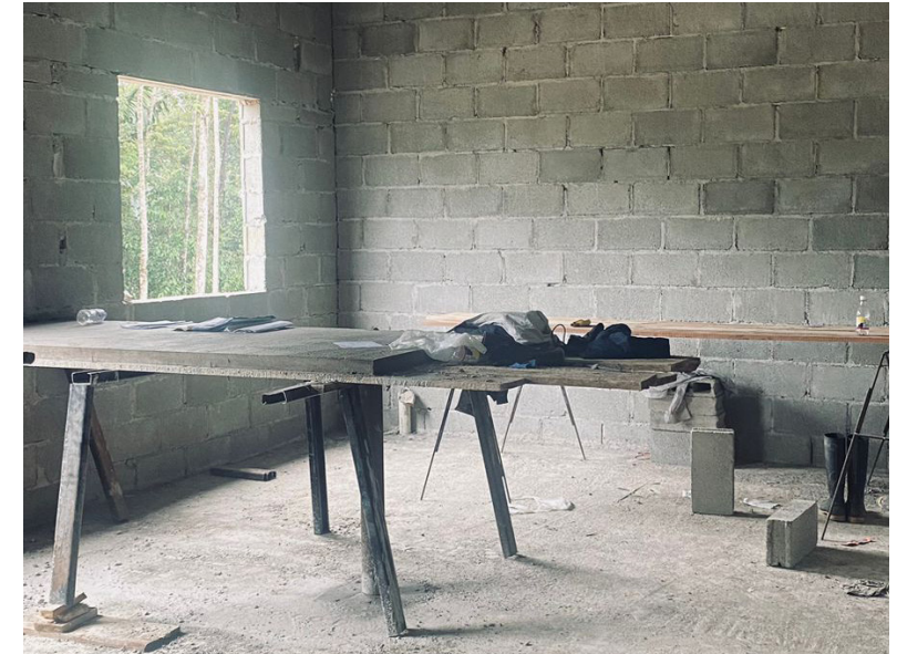
Fotografía 5. Vista interior de área de lavado – marzo 2024
