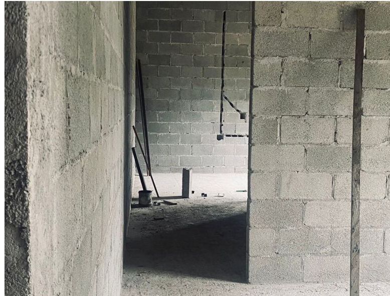
Fotografía 4. Vista interior de área administrativa – marzo 2024
