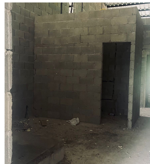
Fotografía 2. Vista interior de habitación tipo I - marzo 2024
