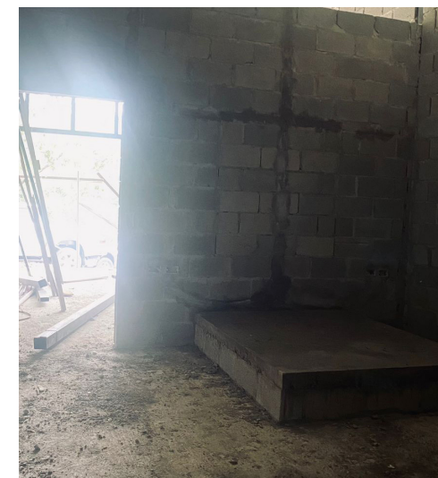
Fotografía 3. Vista interior de habitación tipo I - marzo 2024
