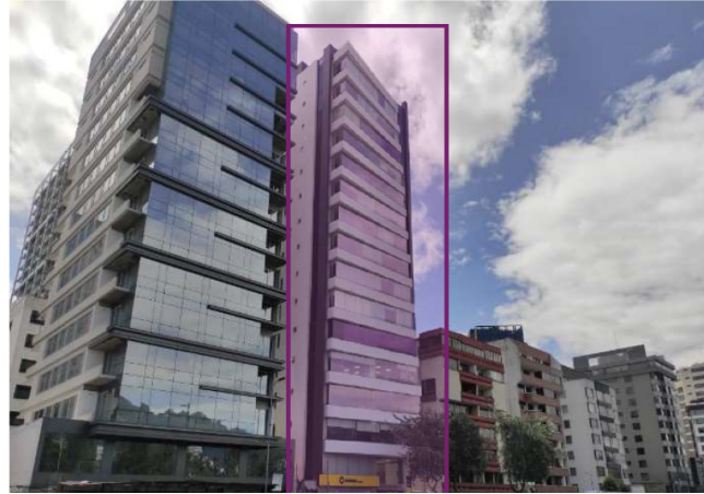
Ilustración 12: Edificio Shyris Center Fuente: Tomada por el autor
