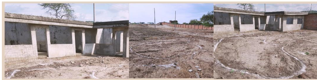
Figura 4. Estado actual del terreno a intervenir
