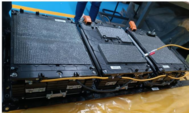
*Figura 25: Conexión de batería de polímero de Ion-litio para almacenamiento de energía de sistema fotovoltaico.*
