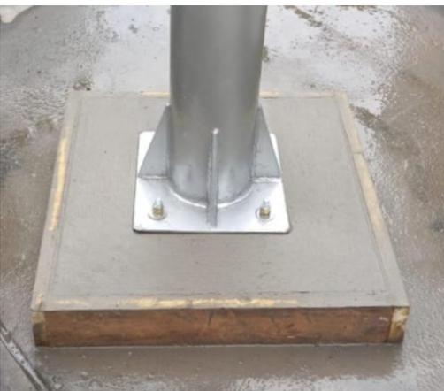
Unir la estructura de la copa del árbol (ver figura 14) que soportara los paneles solares para una mejor acogida del sol así mismo una vez seca la base de cemento se atornilla (ver figura 15) para asegurar mejor la estructura que perdurara mucho tiempo brindando energía.
