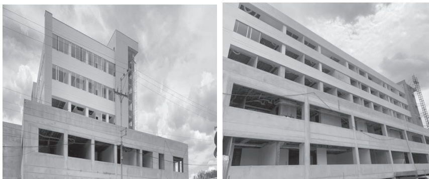
Edificio en construcción del nuevo Hospital de SOLCA
