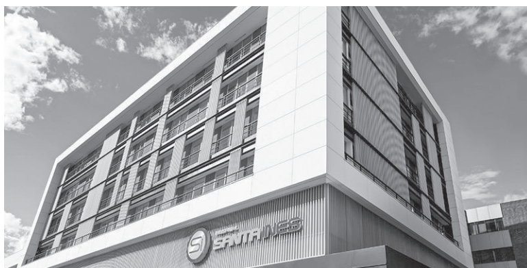
Tercera torre de consultorios Santa Inés, 2019
