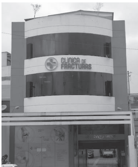
Edificio de la Clínica de Fracturas
