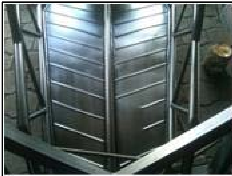
Figura 49: instalación del piso
