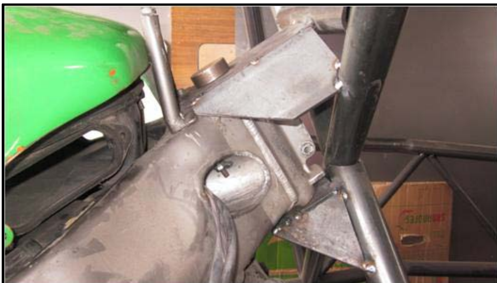
Figura 44: conjunto de anclaje terminado
