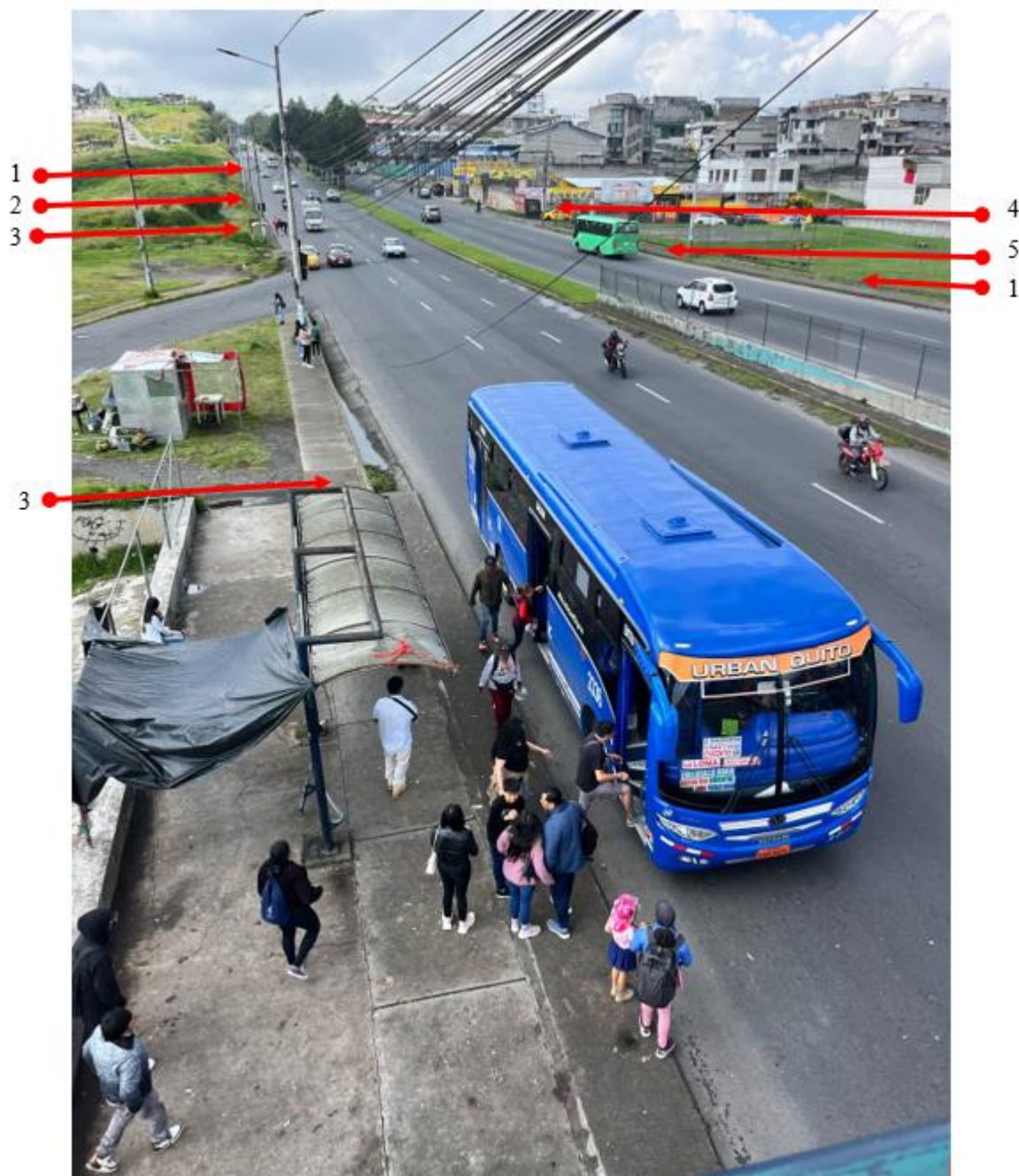
Figura 62 Falta de señalización vial sector La Argelia, vista hacia el sur 1.
