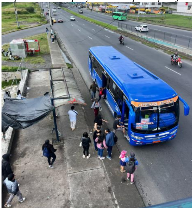
Figura 70 No existe bahía para el embarque y desembarque de pasajeros del transporte público.
