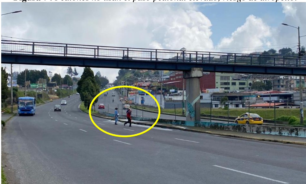
Figura 74 Peatones no usan el paso peatonal elevado, riesgo de atropello.
