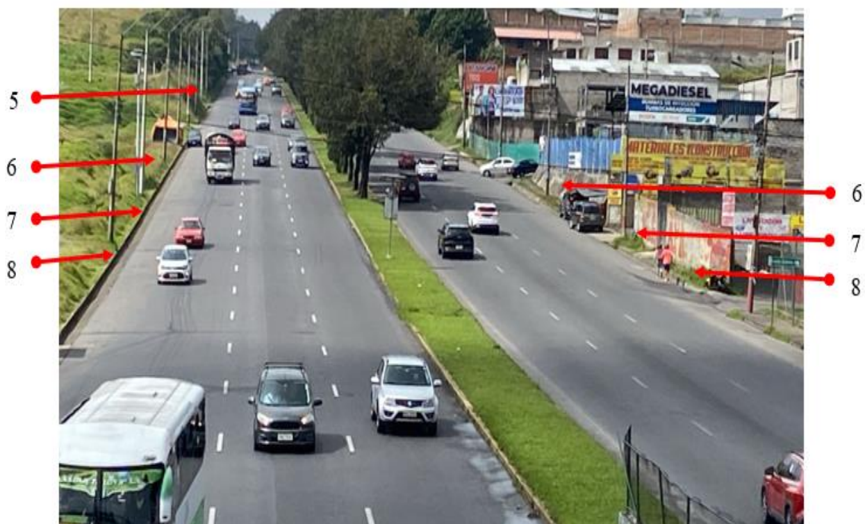
Figura 63 Falta de señalización vial sector La Argelia, vista hacia el Sur 2.
