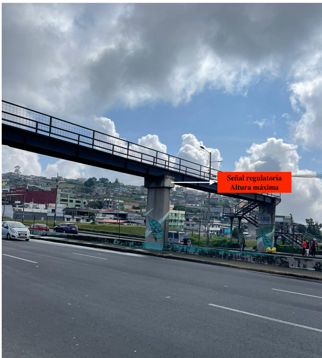
Figura 65 Falta de señalización vial sector La Argelia, vista 2 hacia el norte.
