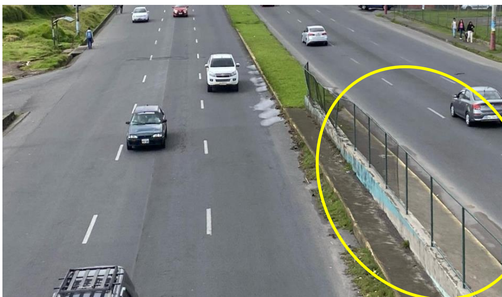
Figura 73 Barrera de seguridad sin malla, permiten el cruce de peatones.
