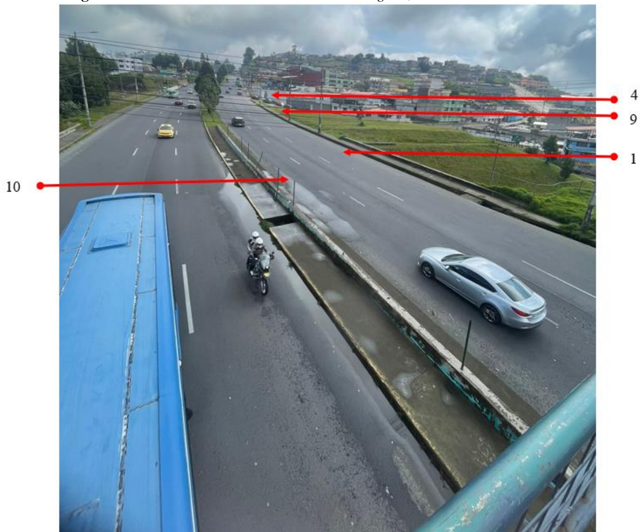
Figura 64 Falta de señalización vial sector La Argelia, vista 1 hacia el norte
