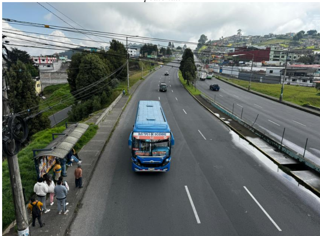
Figura 56 Vista Av. Simón Bolívar, sector La Argelia, sentido norte - sur, desde el puente peatonal.
