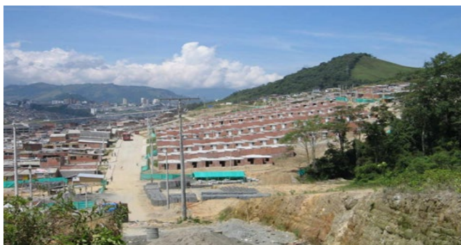
Figura 22. Intervención, Barrio Altos de Santa Ana. Fuente: OMPAD (2003).
