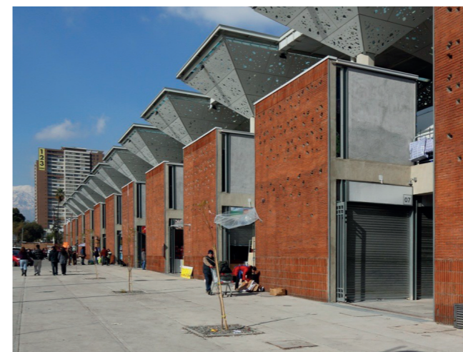
Imagen 3. Fachada lateral del mercado. Fuente: Plataforma Arquitectura, 2022
