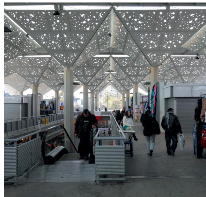
Imagen 1. Circulación vertical, Mercado Tirso Molina. Fuente: Plataforma Arquitectura, 2024
