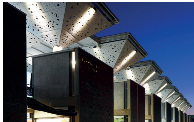
Imagen 6. Estructura de cubierta. Fuente: Plataforma Arquitectura, 2024
