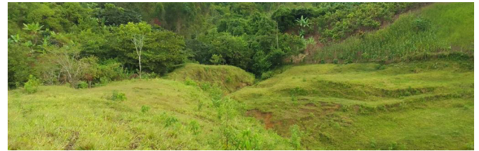
Figura 95: Vista B – Terreno. Elaboración: La Autora.
