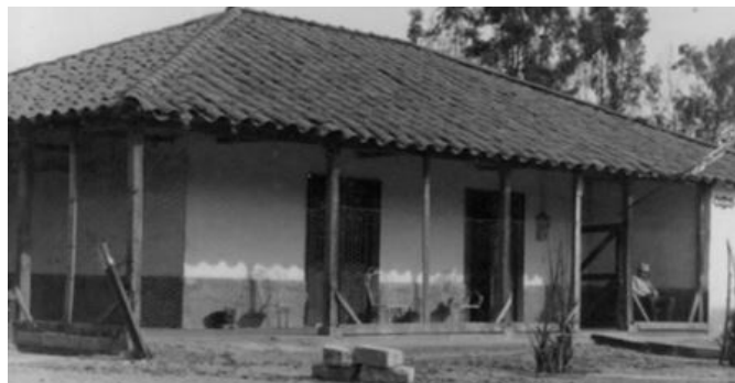
Figura 24: Parador- La Sabiduría Fuente: Plataforma Arquitectura (2016).
