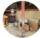
En el bloque 2, se encuentran 24 columnas que han experimentado deterioro debido a la humedad, lo que ha provocado una pérdida de resistencia dando un como resultado un 100% en mal estado.
