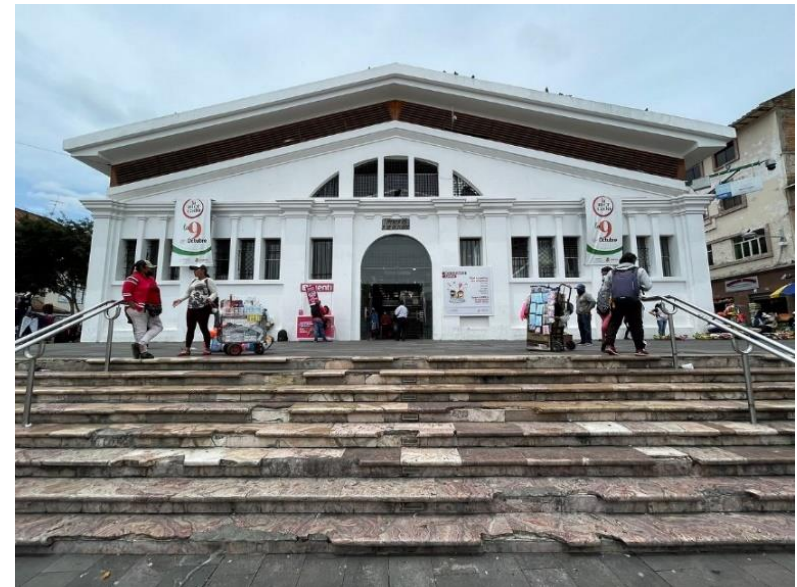
IMAGEN 62: fachada central del Mercado 9 de octubre, Fuente: TripAdvisor 2022, el 21/07/2022
