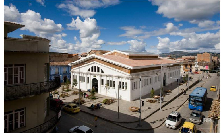
IMAGEN 61: Vista general del Mercado 9 de octubre, Fuente: Boris Albornoz – Arquitectura, el 20/07/2022
