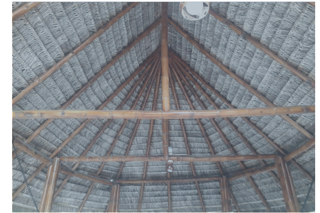
Imagen 37: Techo de paja toquilla Fuente: Autoría Propia 2023.
