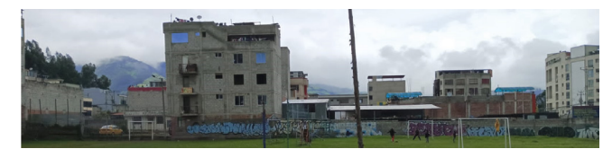
2 VISTA FACHADA LATERAL IZQUIERDA
