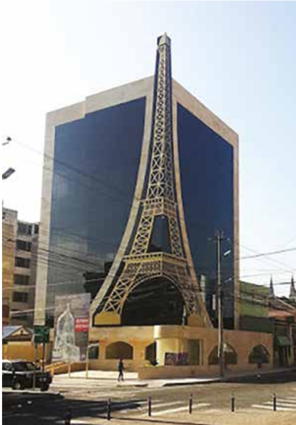
Imagen 2. Edificio Torre Ifel, Quito, 2015. Fuente: http://alicante-ecuador.blogspot.com .
