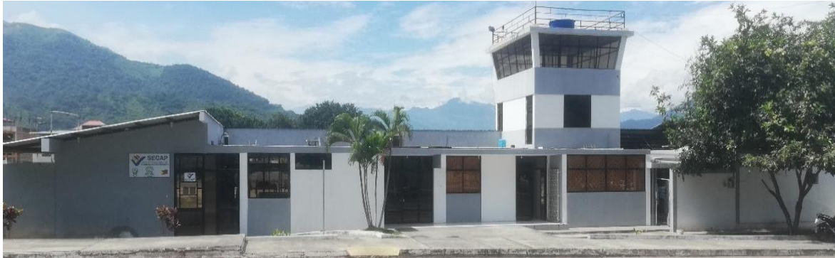
Ilustración 1. Torre de control vista Frontal Fuente: Autor de tesis
