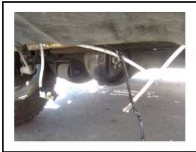
Figura 5.11 Utilización del Cable UTP
