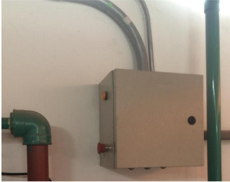
*Figura A.12 Tablero de Potencia Apariencia externa*
