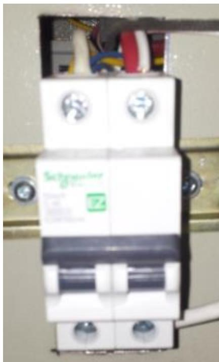
3. En el tablero de control, colocar el interruptor de la derecha en estado "ON", el mismo enciende a los controladores de temperatura y al calefactor.
