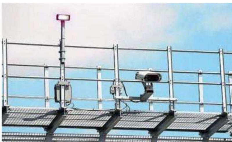
Imagen 43. Dispositivo foto radar, fuente [radar por tramo - Bing images](#)
