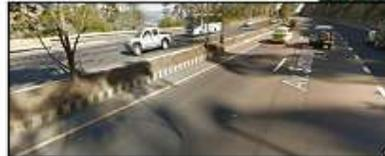
Cunetas sin protección, falta de mantenimiento arbolado existente en parterre.
