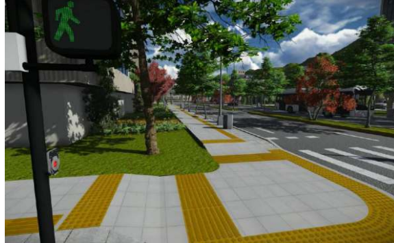
Figura 24 Señalización podotáctil intersección
