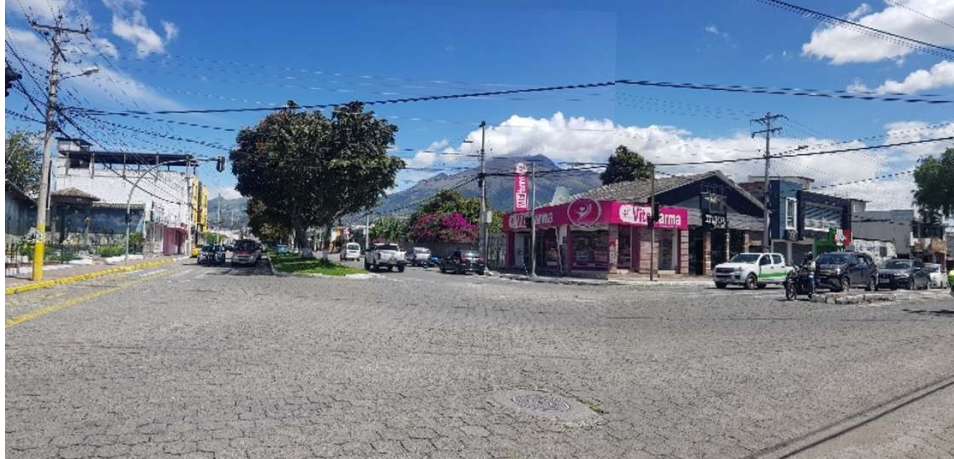
Figura 5 Vista general inicio Av. El Retorno, Km 0+000
