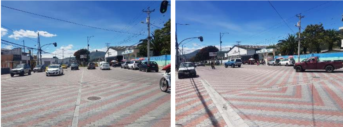
Figura 9 Vista general inicio Tramo 2, Km 0+615
