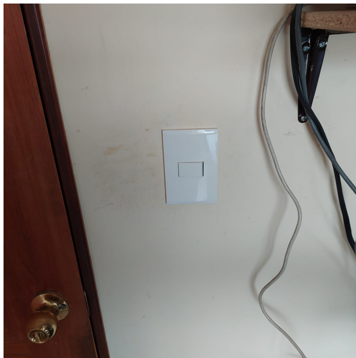
Figura 85. Instalación interruptor automatizado.
