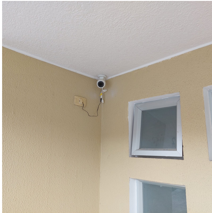
Figura 87. Instalación cámara vídeo vigilancia.
