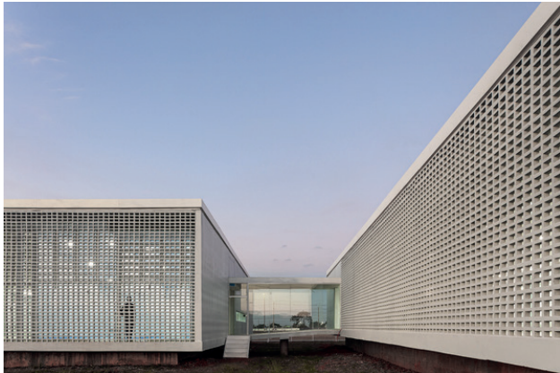
Figura 4 Centro de atención primaria Fuente: Plataforma arquitectura
