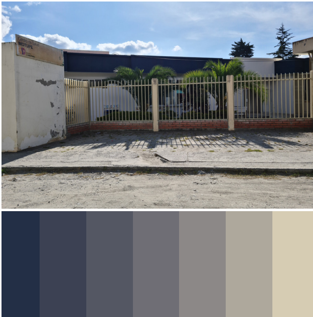
Figura 37 Centro de Salud Motupe Fotografía realizada por el autor
