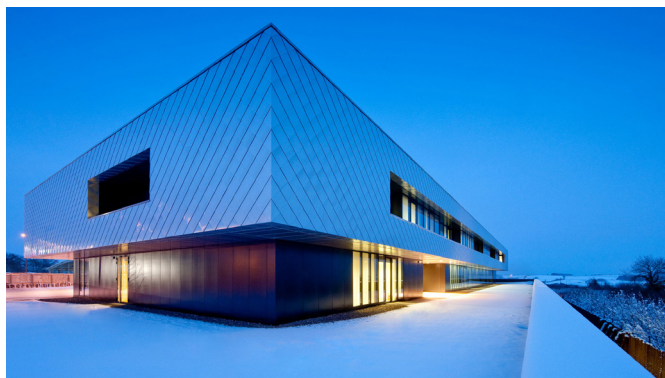
Imagen 05. Sulis Hospital Bath. Vista exterior. Fuente: Foster and partners.
