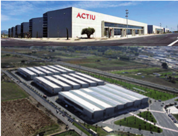
Figura 34. Edificaciones de producción del Parque ACTIU
