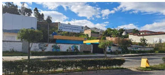
Vista del acceso principal
