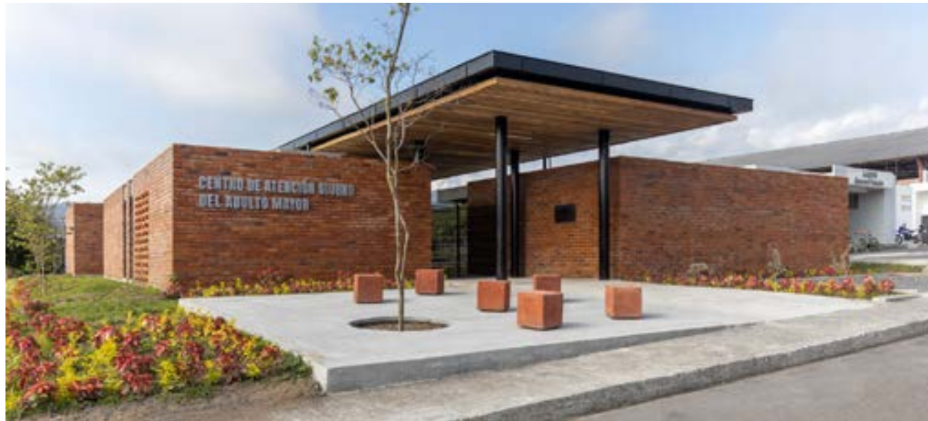
Fuente: Side FX arquitectura, 2023.
