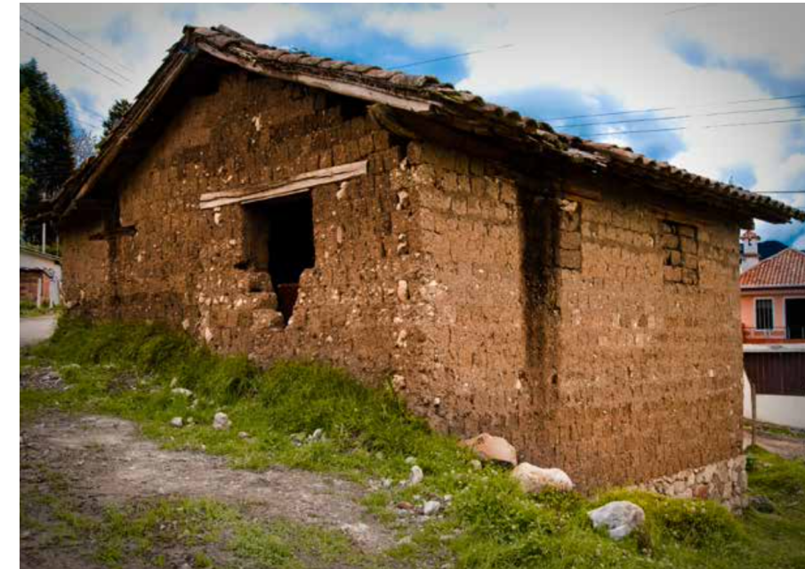
Figura 10. Casa de Adobe Mariscal Lamar
