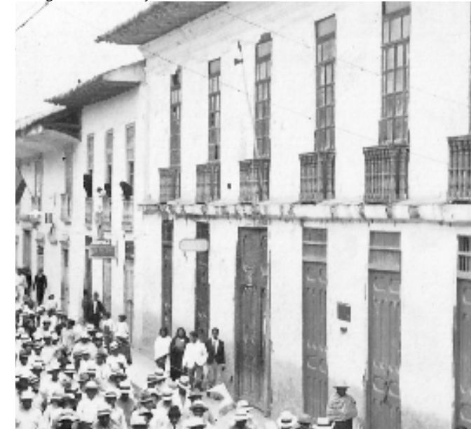
Figura 7. Viviendas con sistema constructivo ancestral. Bolívar Y Miguel Riofrio. Loja.1920
