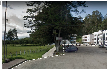
Imagen 34. Vía interna de la Facultad de Geología V1
