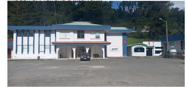
Imagen 37. Terreno a intervenir.
