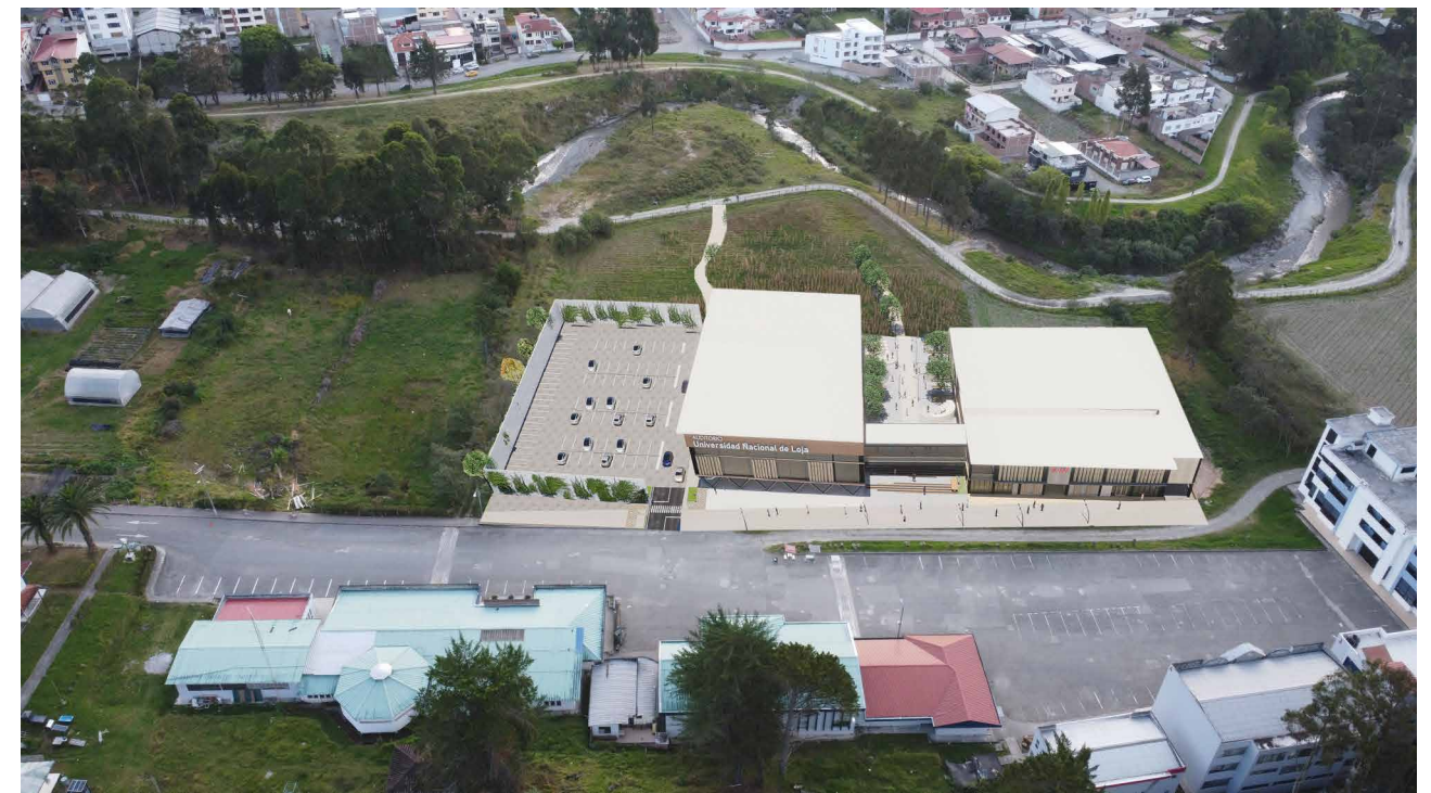
Figura 55: Terreno con el equipamiento
