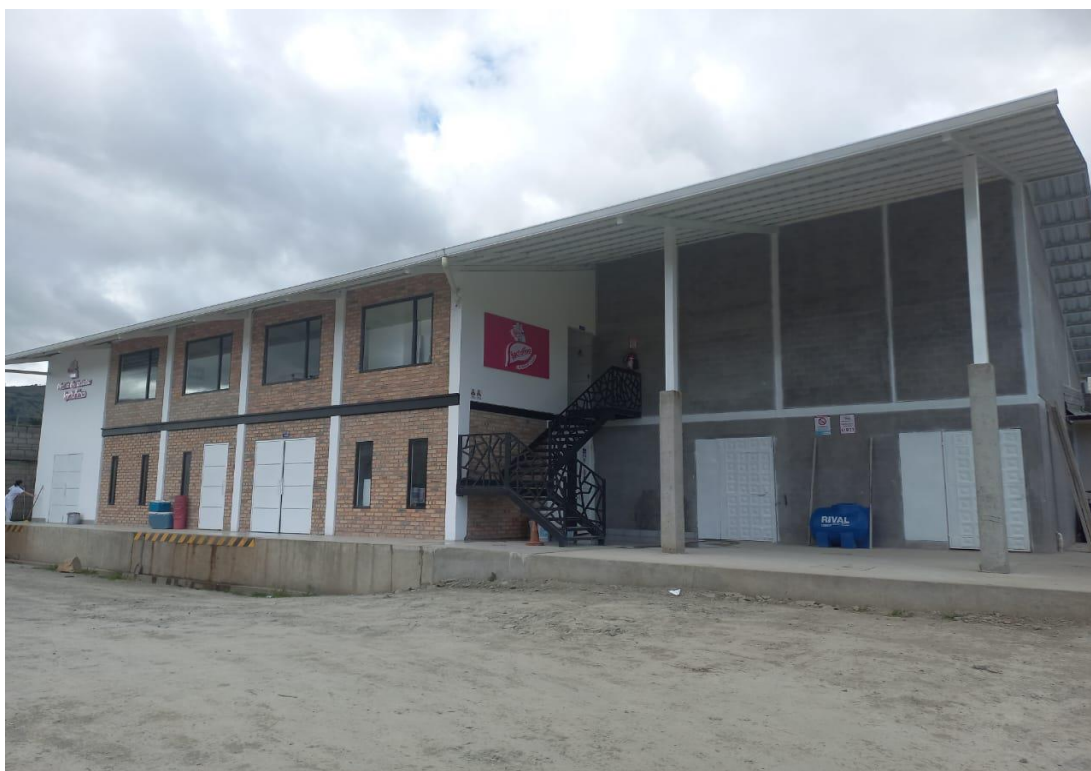
Figura 1. Edificación Empresa "Lactofino"
