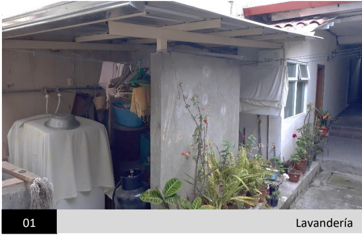
Figura 54 Registro fotográfico - Caso 3 – Planta baja
