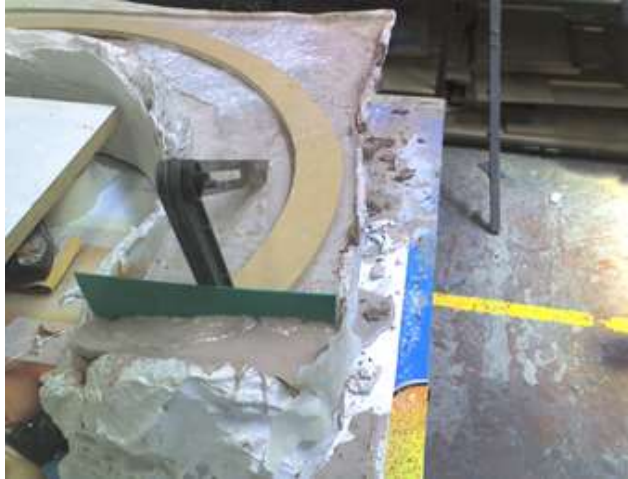
Figura 2.66 Formado del molde de macilla y colocado de arco de madera para estructura
