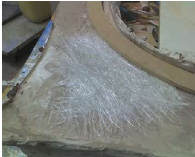
Figura 2.67 Capa de fibra de vidrio para dar resistencia al molde
