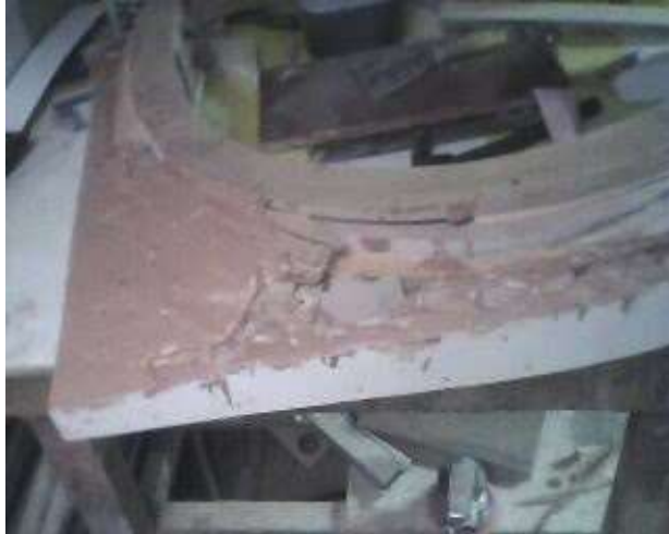
Figura 2.80 Formado de superficie con masilla
