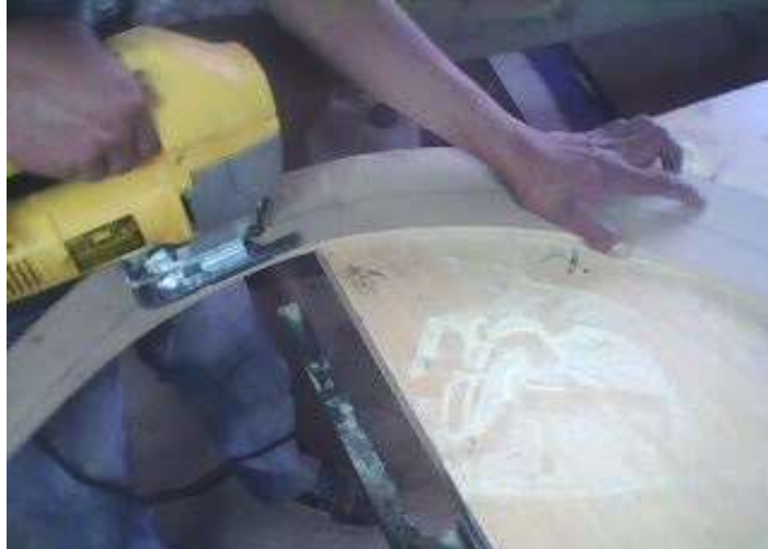
Figura 2.73 Calado interno del arco
