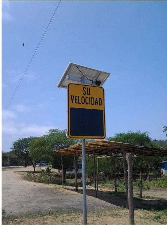
**Figura 1.13: Panel fotovoltaico al poste**
