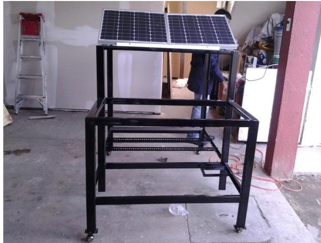
**Figura 3.14: Instalación de paneles fotovoltaicos sobre estructura**
