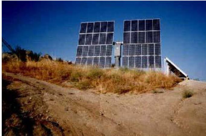
**Figura 1.11: Panel fotovoltaico al suelo**
