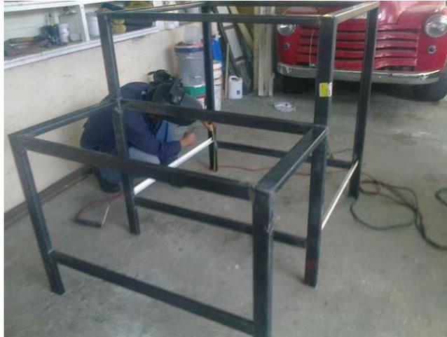
**Figura 3.12: Ensamble de estructura fija**
