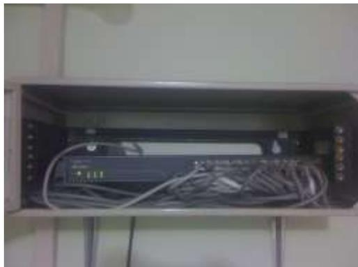
Parte interna del rack gabinete con el switch instalado y conectado los cables de red de los distintos puntos del centro médico
