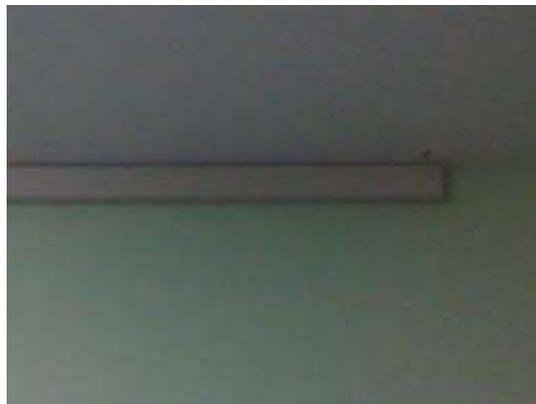
Vista de uno de los ingresos del cable por medio de la pared, para esto se utilizó la perforación mediante el uso de un taladro
