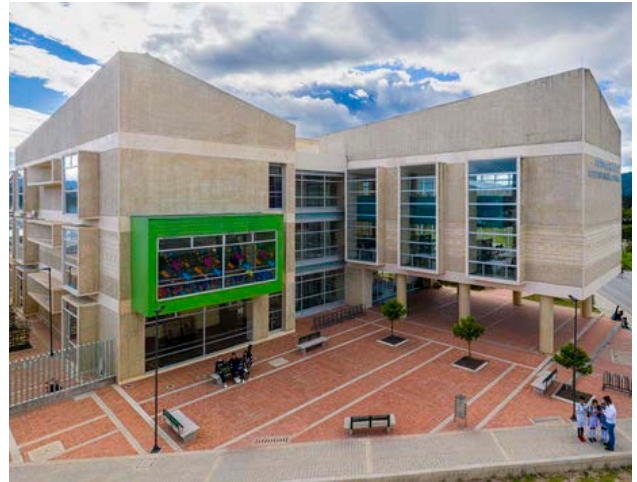
Figura 43- 44. Biblioteca de Tocancipá Fuente: Archdaily (2019)
