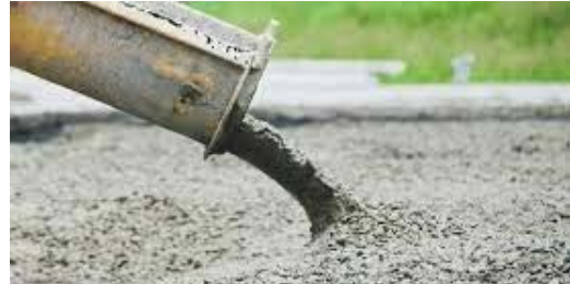
Figura 10. Colado de hormigón
