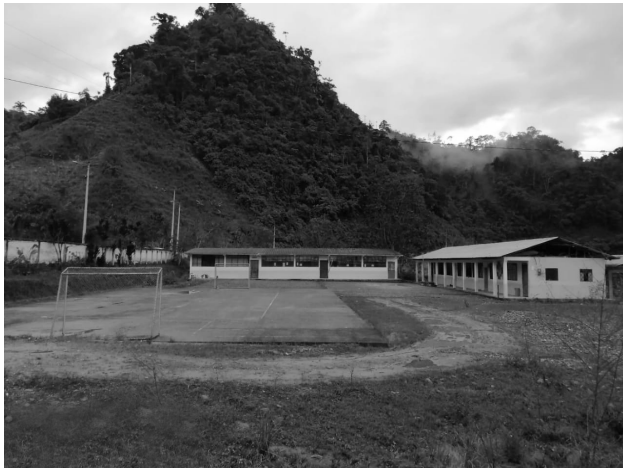
Imagen 20. Visual de los bloques de aulas y administración.
