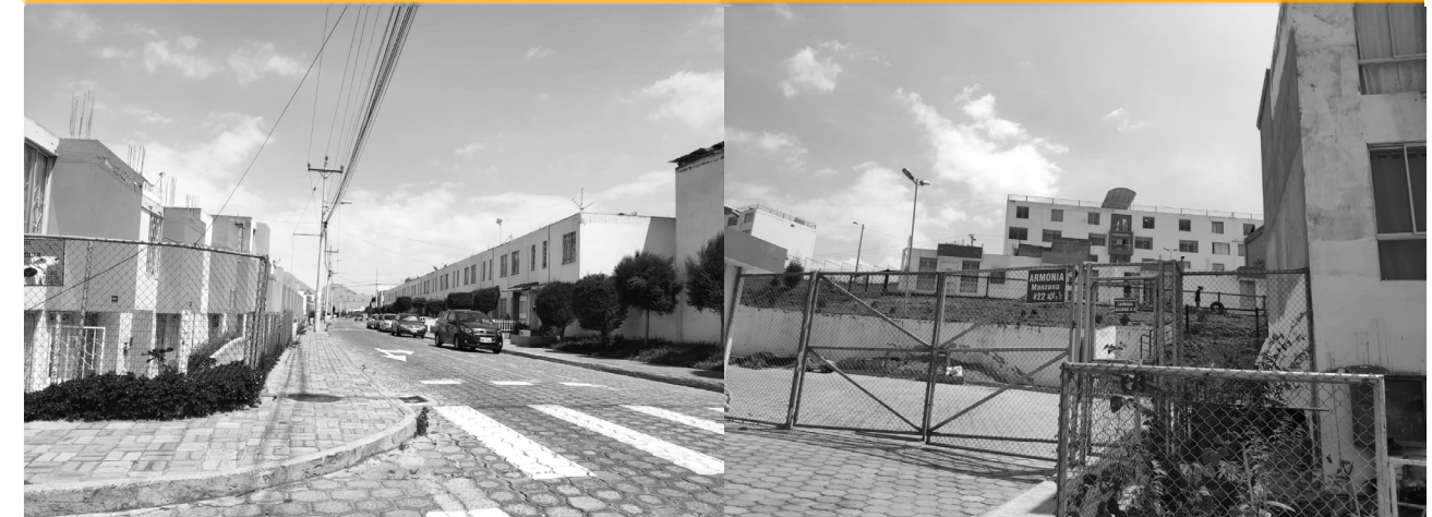
Figura 17: Tipologías de vivienda y cerramientos. Fuente: Elaboración propia.
