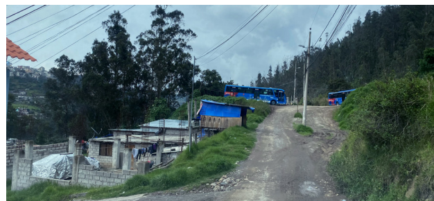
Imagen 14. Estructura de movilidad precaria e insatisficiente Fuente: Recopilación Propia
