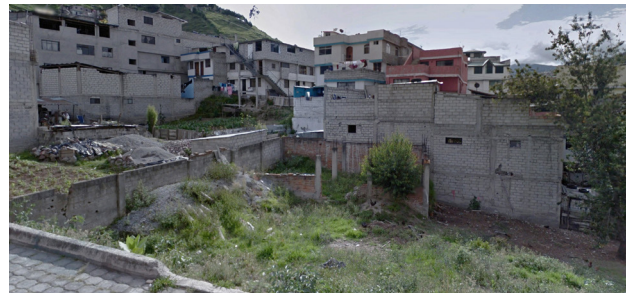
Imagen 5. Prácticas precarias de construcción de viviendas del barrio Paluco Fuente: Recopilación Propia
