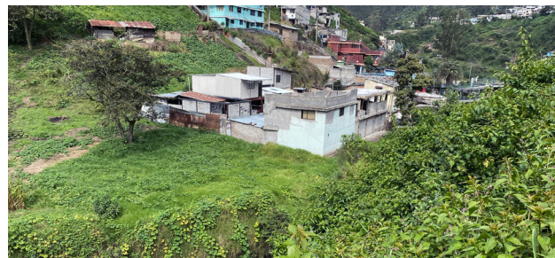
Imagen 13. Vivienda establecida a escasos metros de la Quebrada Fuente: Recopilación Propia
